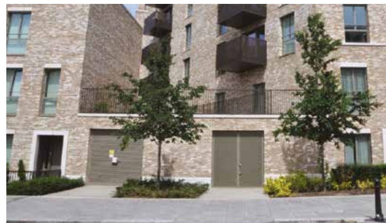
Technische ruimtes onderdeel van architectonische compositie
