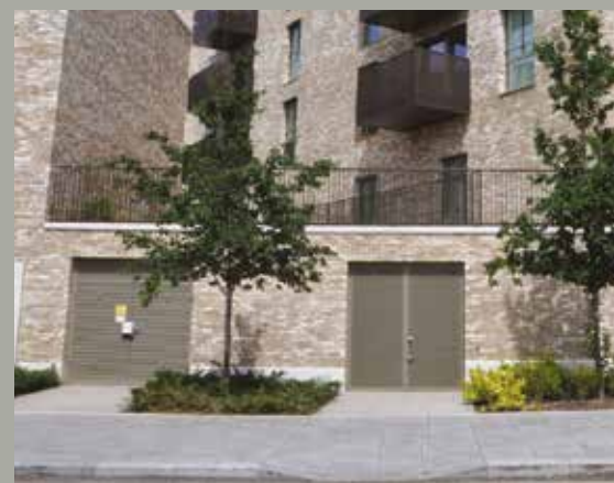
Technische ruimtes onderdeel van architectonische compositie
